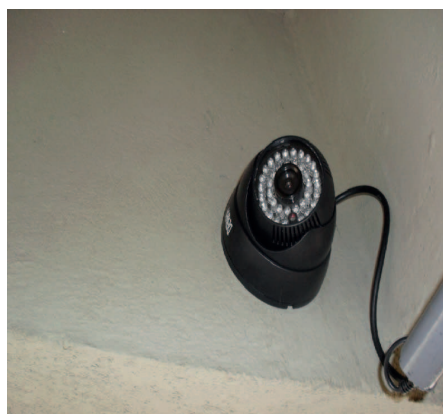
Instalação de mais 32 câmeras infravermelhas
