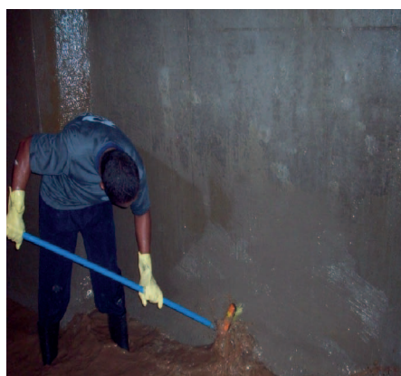
Lavagem das caixas d'água dos 10 blocos
