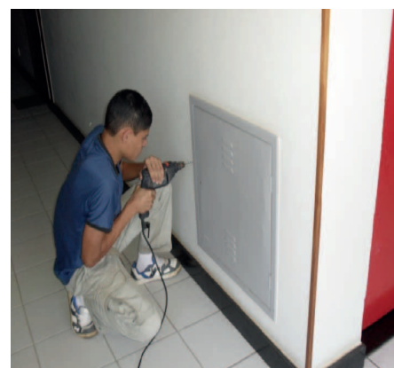
Colocação de cadeados em todas as portas de acesso à fiação de internet e TV
