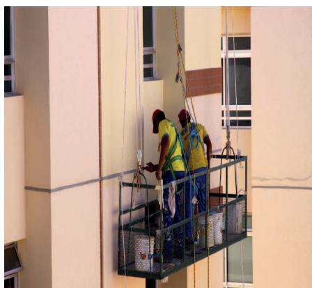
Pintura das fachadas dos blocos
